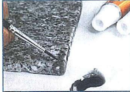
⑤ パテ硬化後、余分な部分をサンド ペーパーを使用して研磨します。 エナメルペイントをシンナーで希釈し 必要な箇所を着色していきます。 ※着色の際は、市販のパレット等を ご使用ください。
