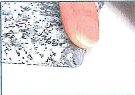
④ キズの部分に、よく練ったパテを 少量ずつこすりつけるようにして 埋めて盛っていきます。 自然乾燥で15~20分、急ぐ時は ドライヤーにて乾燥させます。
