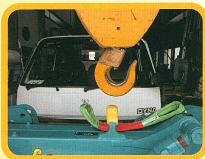
機械の吊り部分に通す
