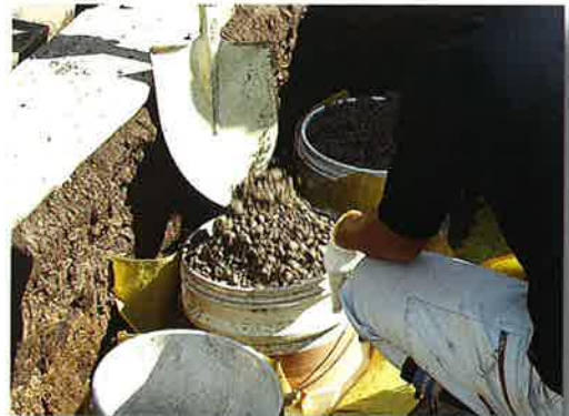
4) D・BOX-Kに決められた容量の中詰材料を投入する。
