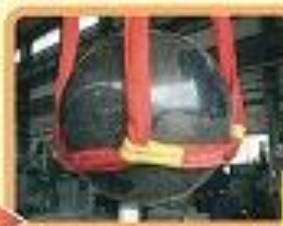
クレーンで吊る
